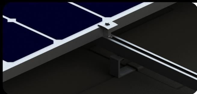
Com o grampo intermediário no perfil. Certificar-se de que todos os contatos sejam feitos. Fixar os parafusos dos grampos com torque de 15Nm e depois do aperto verificar se os módulos ficaram corretamente fixados.
